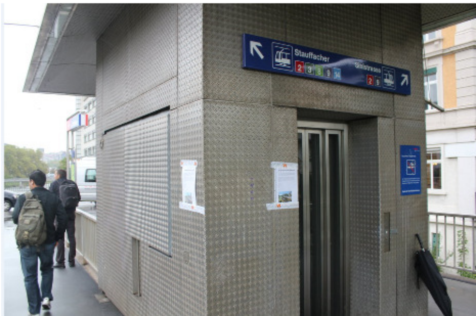
Perronlift, Bahnhof Selnau, 8001 Zürich (aus: Tagesanzeiger, 19.9.2012)
